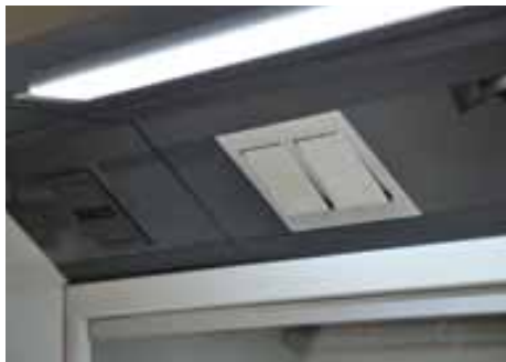
4 zásuvka s vypínačem ve funkční liště
